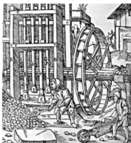
Vodní mlýn s principem drcení
